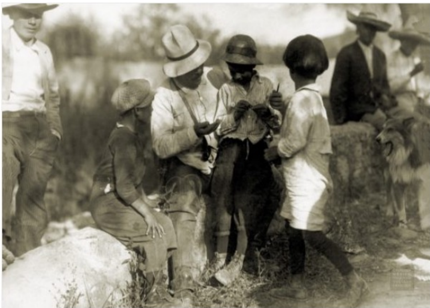
Pancho Villa, en la construcción de una de las escuelas
